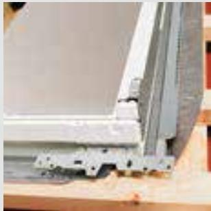
Теплоизоляционный контур надежно утепляет периметр окна
